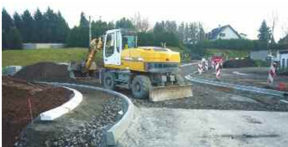
Le tracé du nouveau giratoire se dévoile progressivement.
