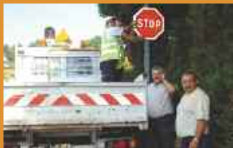
Pose d'un panneau Stop rue de Guerting.
