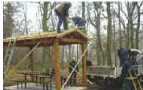
Sous les yeux attentifs du maire et de l'adjoint chargé du patrimoine, des bénévoles de la commune achèvent l'installation d'un abri à proximité du terrain de pétanque.
