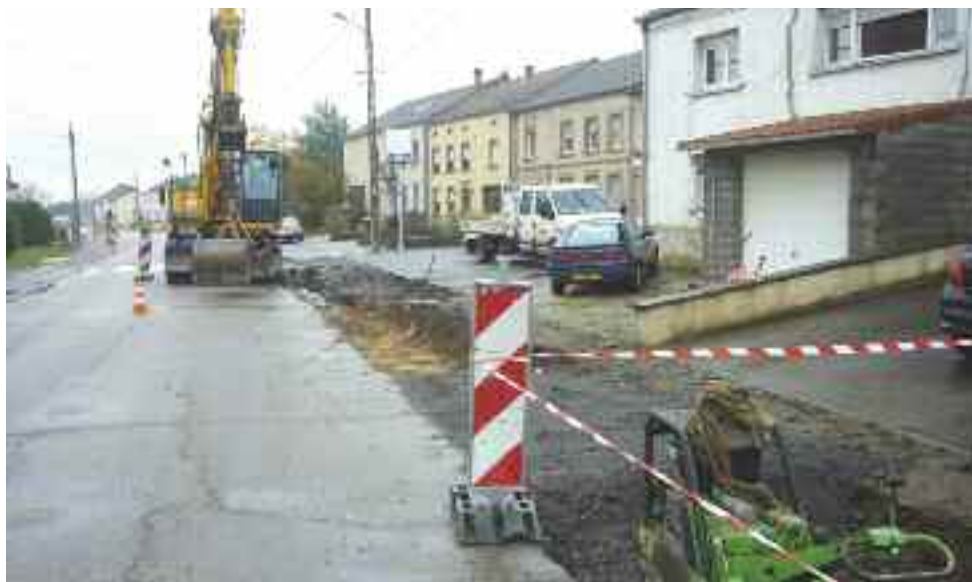
Des traverses ont été posées pour pouvoir, plus tard, enfouir les réseaux sans recasser la route.
