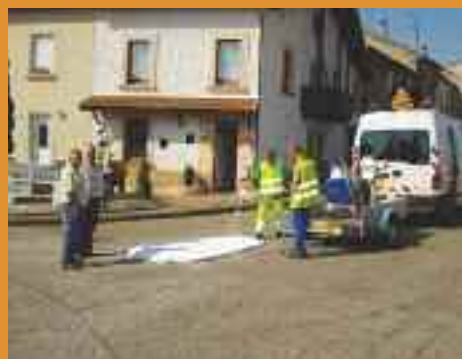
Réfection des marquages au sol rue de Guerting.
