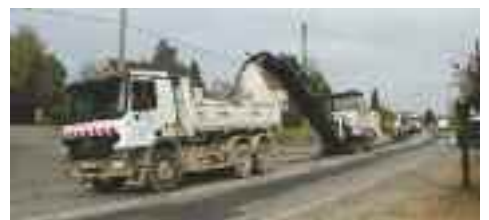
La route de Boulay et la rue de Guerting ont été rénovées sur 840 mètres.
