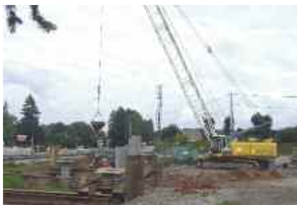
Des pieux de 6 m de profondeur ont été plantés dans le sol le long de la Bisten.
