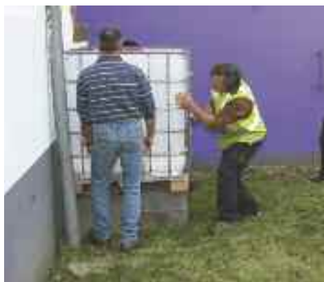
Le nouveau toit de la mairie est raccordé à un conteneur d'1 m 3 .
