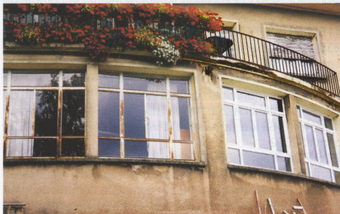
Pose de nouvelles fenêtres au bloc scolaire des Genêts
