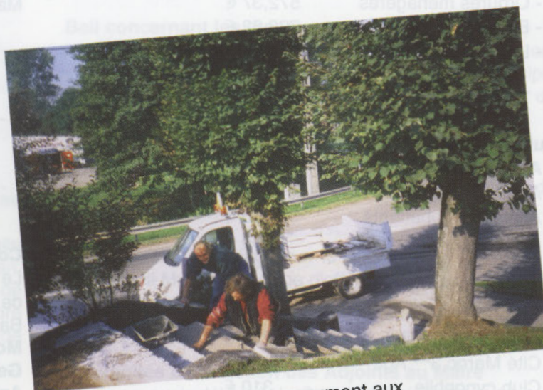
Réfection de l'escalier du monument aux morts par les services techniques
