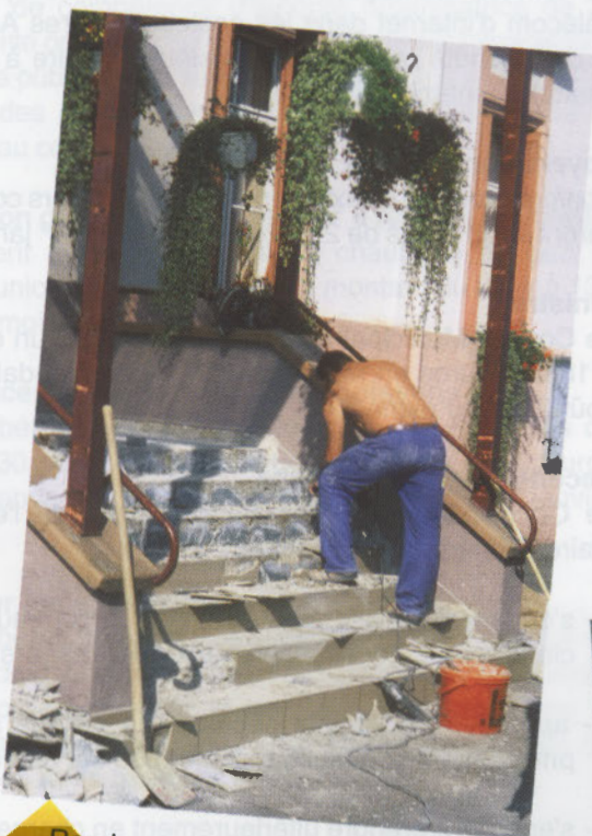
Remise en état de l'escalier de la Mairie
