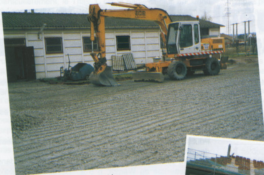
Aménagement du parking des services techniques
