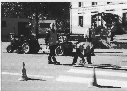
Traçage d'un passage piéton
