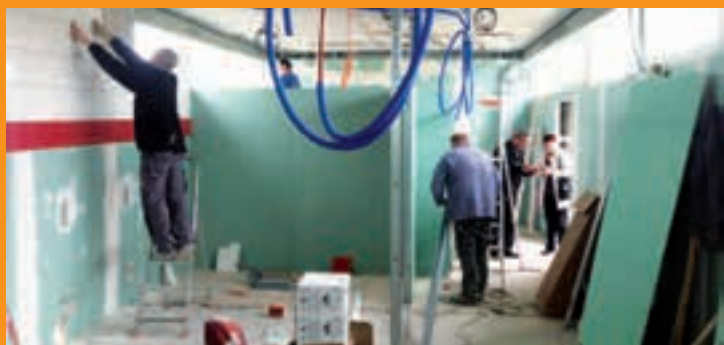
Le local toilettes a été complètement rénové et sa capacité a été doublée
