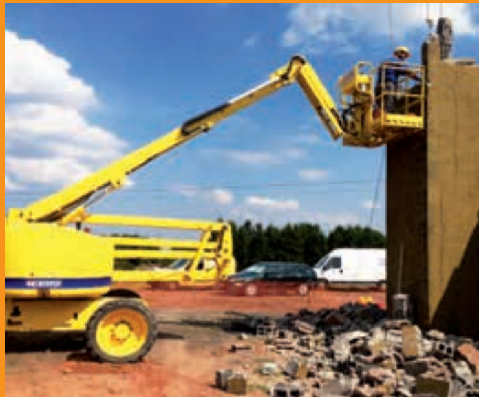
L'ancienne et imposante cheminée, étant devenue inutile, a été démolie. Le grignotage a été préféré à tout autre procédé jugé trop risqué.
